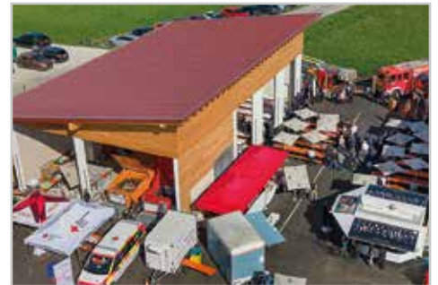
Die neue Halle steht der Freiwilligen Feuerwehr sowie dem Bauhof zur Verfügung.
