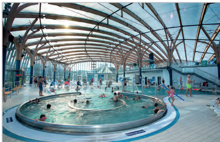
Auf den ersten Blick hat sich nach der Generalüberholung nicht viel verändert; die Neuerungen befinden sich im »Inneren«, da vor allem die Technik grundlegend saniert wurde.
